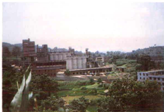
金鑫公司的生产高炉
