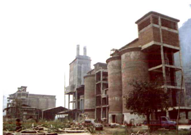
建设中的长江水泥厂
