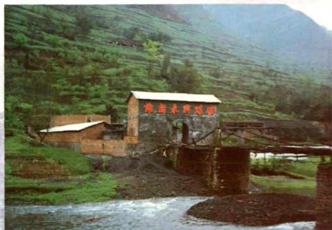
维新镇永兴煤矿一角
