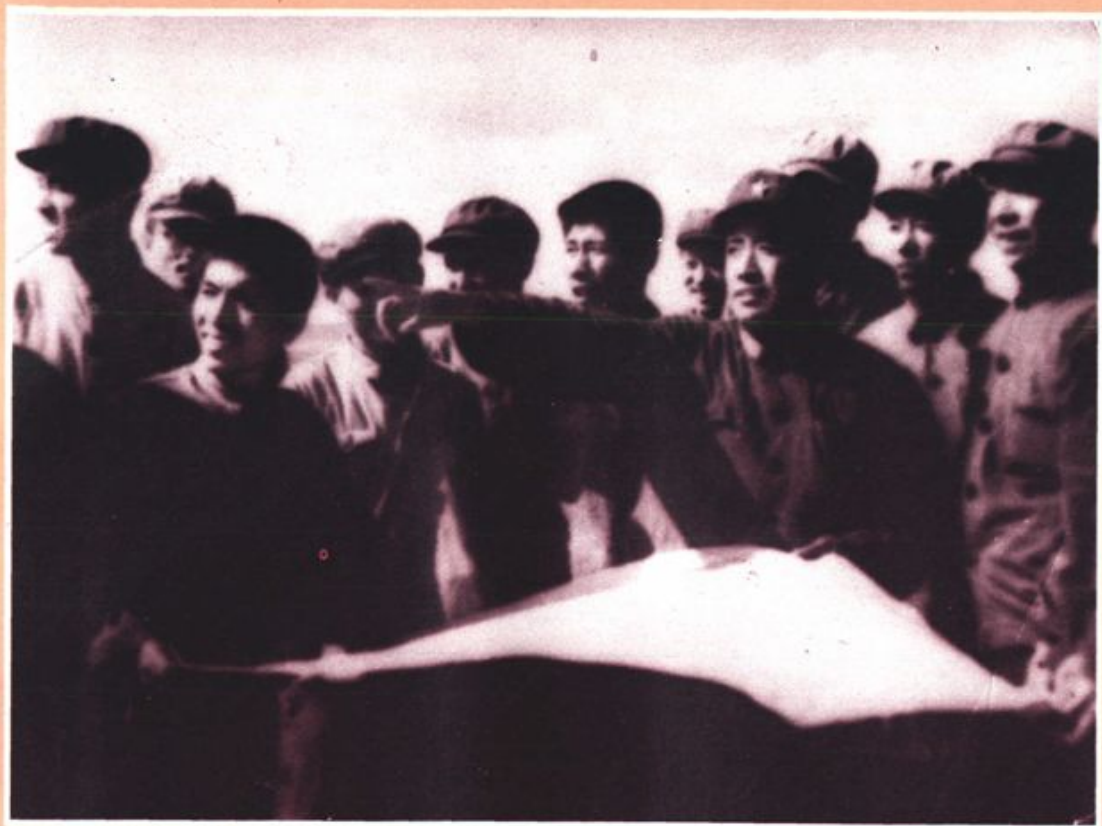
建矿初期的现场办公
