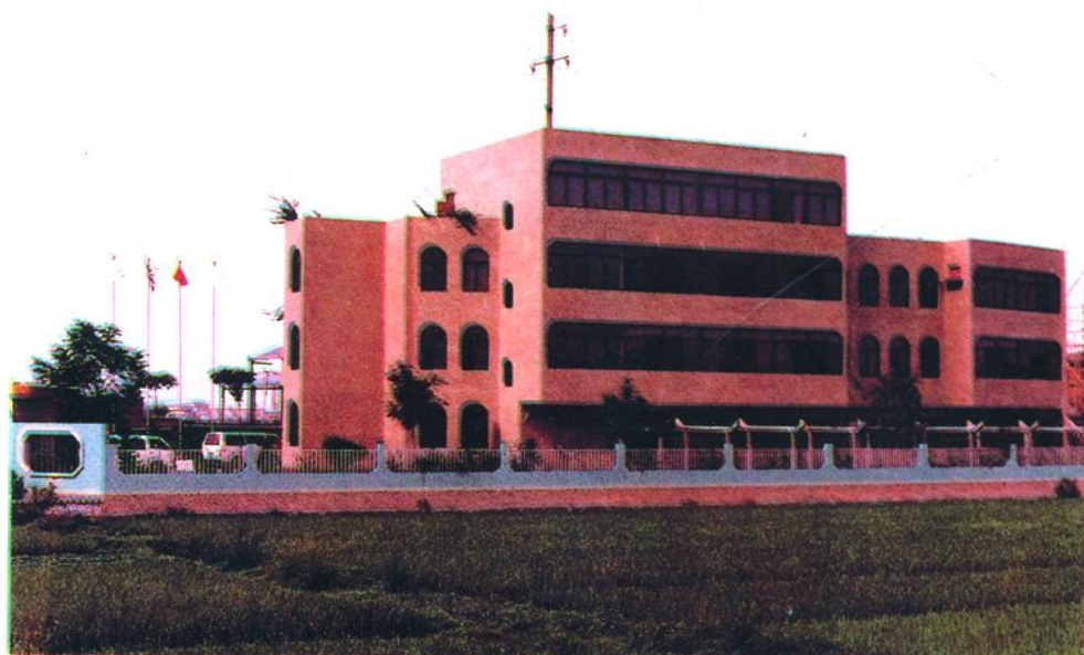
开平县明胶厂办公楼
