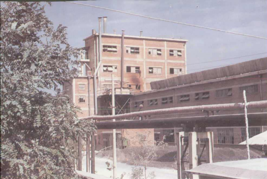
炉衬车间一角
