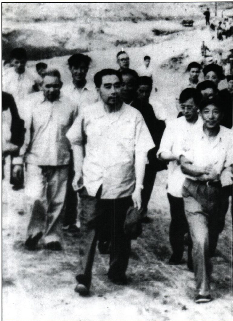
1959年6月7日，国务院总理周恩来视察黄壁庄水库施工工地。
