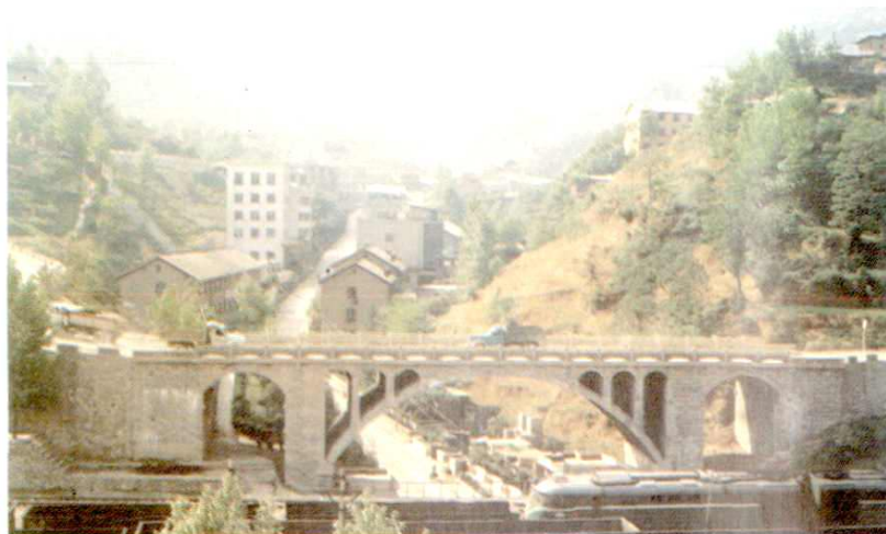
1 马路坪矿外景
