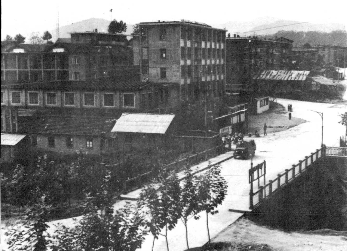
新建工矿区一角。
