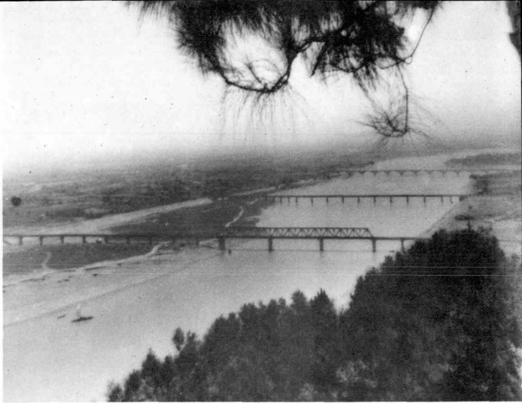
上图：青衣江公路大桥和铁路大桥。
