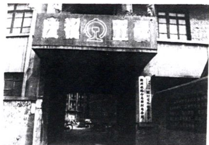
开封电务段位于开封市南关区官坊东街103号
