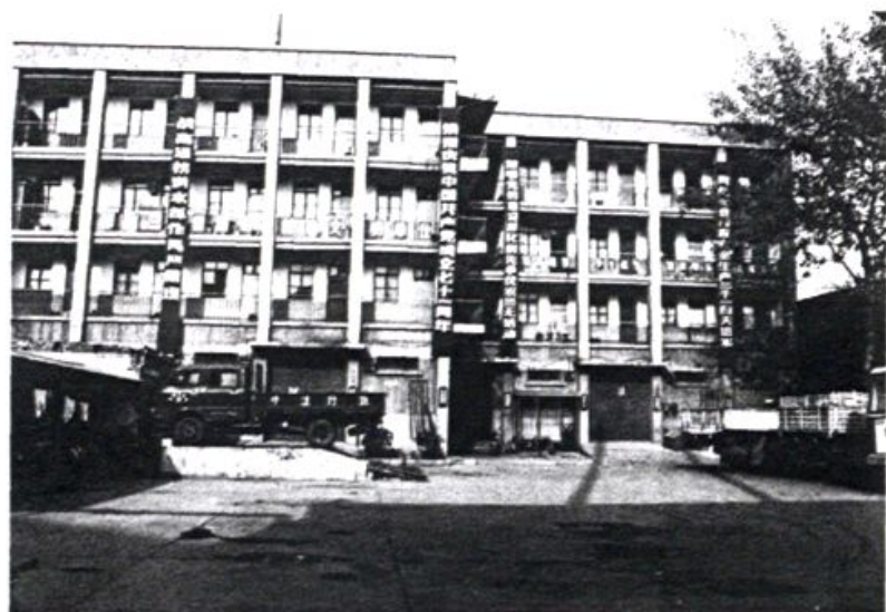
开封电务段机关办公大楼
