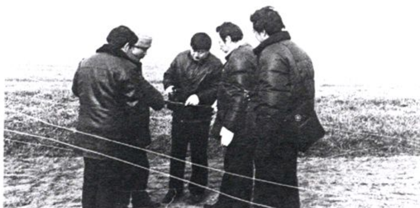
段长肖睦睦(右二) 副段长刘铁栓(中)在施工现场
