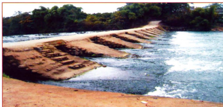
鹤山镇五龙村翻水桥
