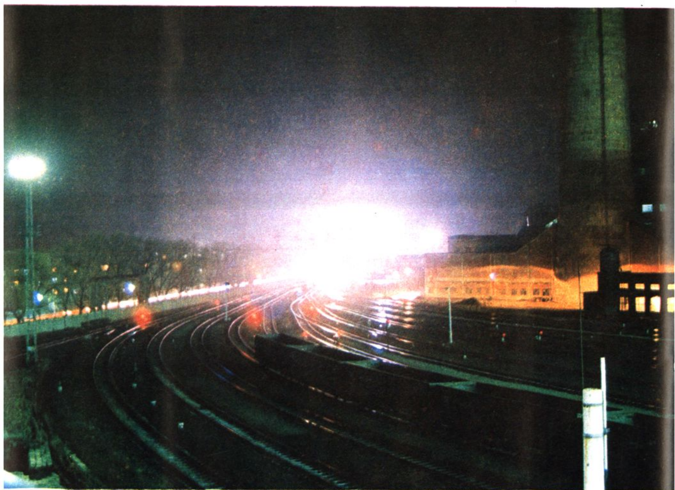
吉林热电厂调车场
