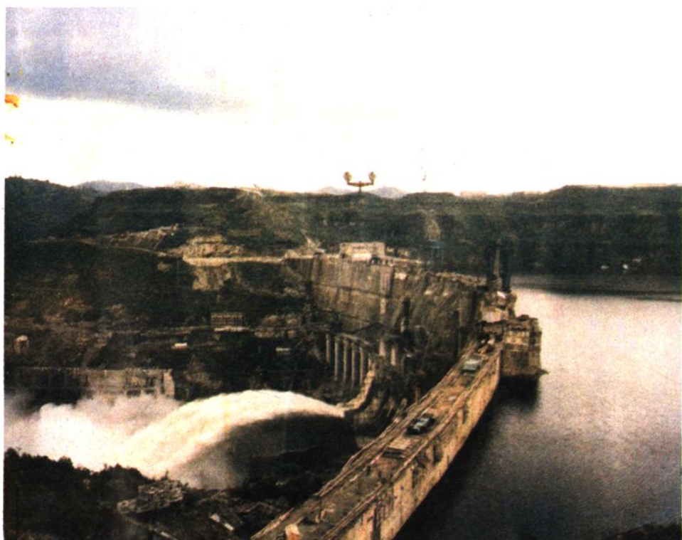
白山水电站大坝
