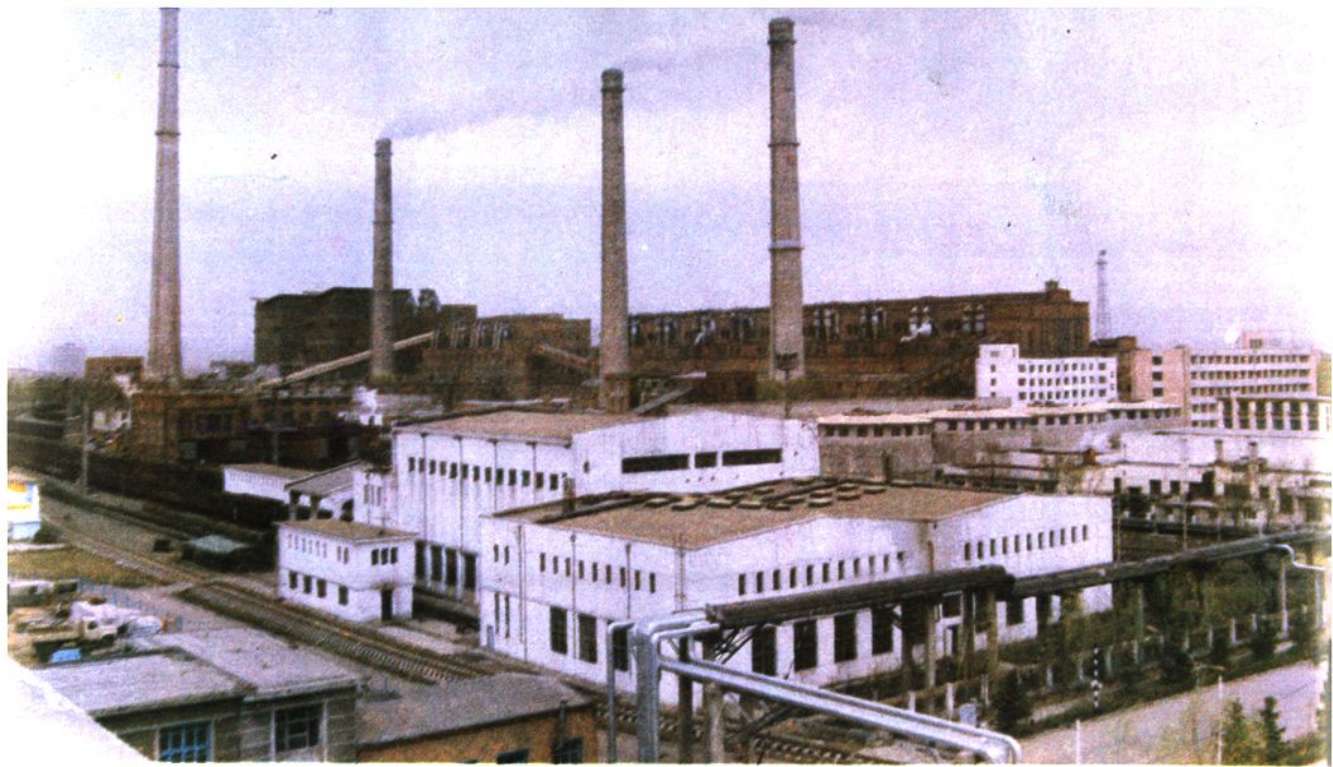
吉林热电厂外貌
