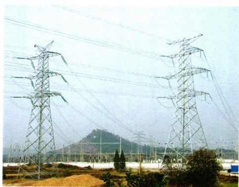
2005 年 12 月开工在建的 220 千伏大联变电所
