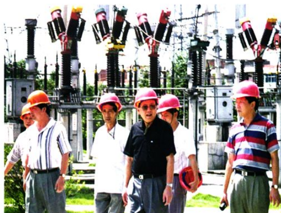
1997年8月21日，原浙江省电力工业局局长丁有德(前中)在金华电业局副局长程小鲁(前左一)陪同下到220千伏东阳变电所检查指导工作
