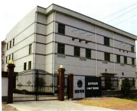
全室内式的 110 千伏广福变电所
