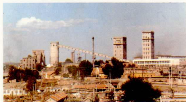
北票矿务局冠山矿千米立井
