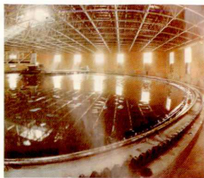
选煤厂浓缩车间
