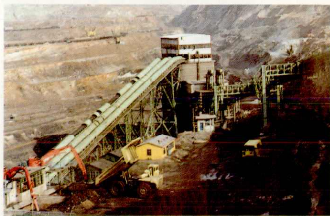
西露天矿破碎提升工程
