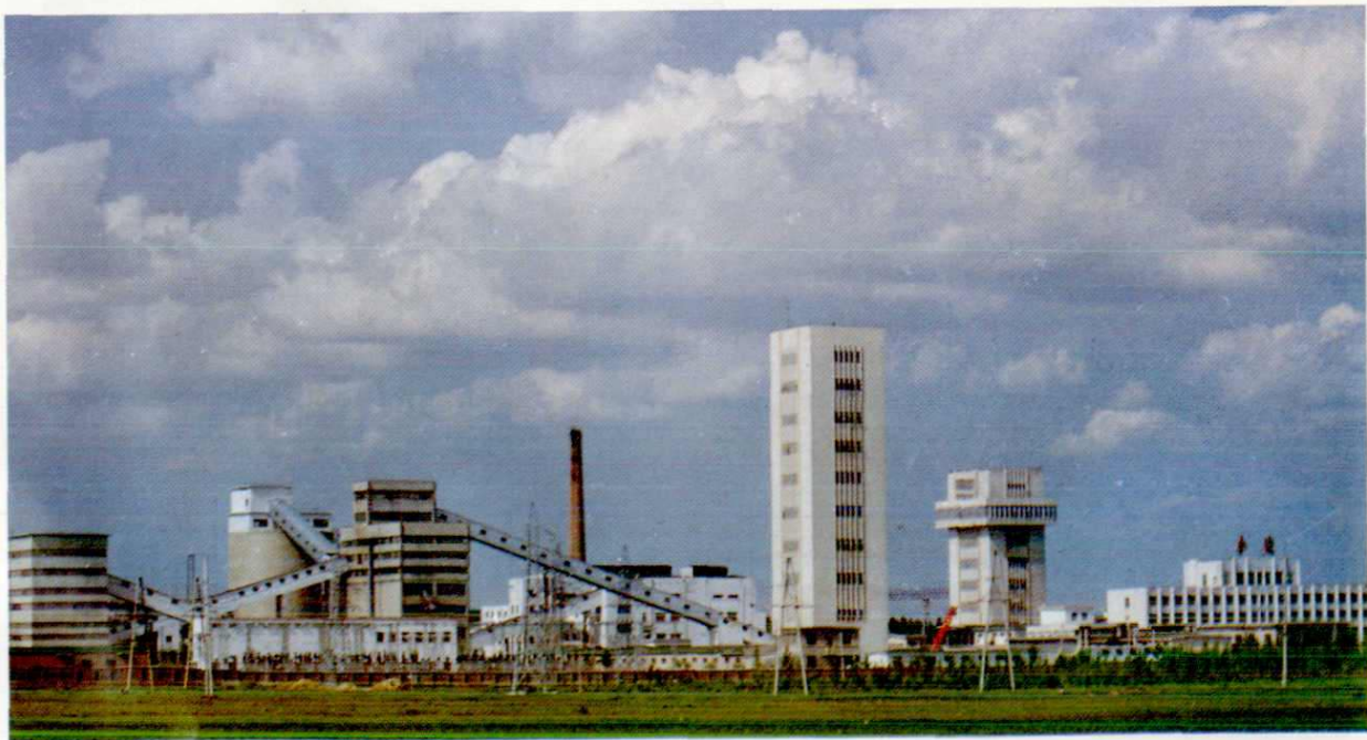
铁法矿务局 40 个月建成投产的小康矿外景
