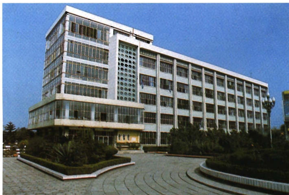
一号教学大楼
