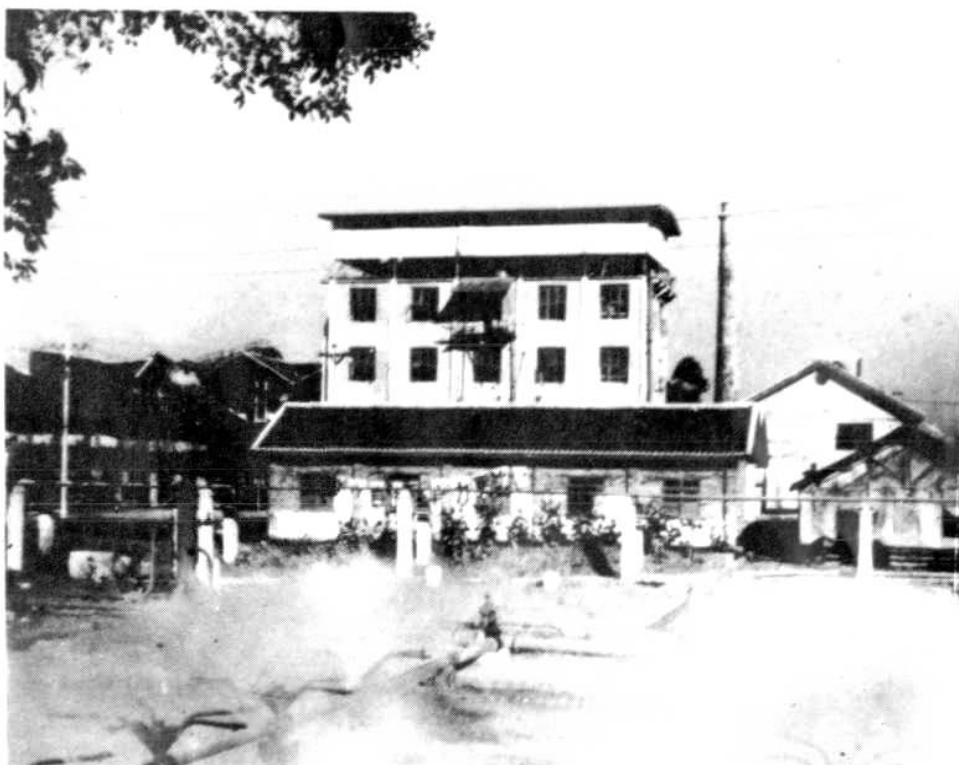
第一座真空制盐车间（1967年）。
