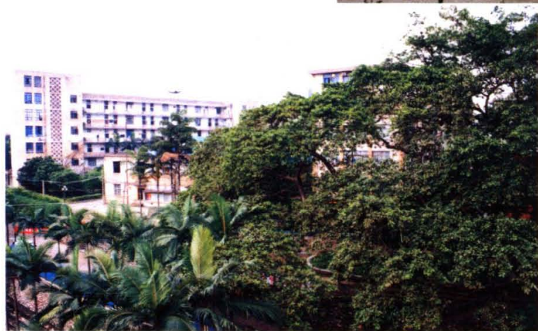
绿阴环抱的教学大楼(位 于北校区,建成于1983年)
