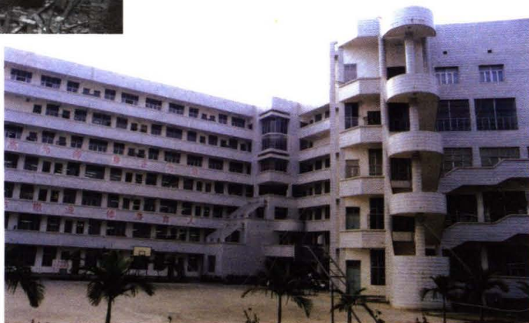
位于南校区的教学实验 综合楼(建成于1996年)
