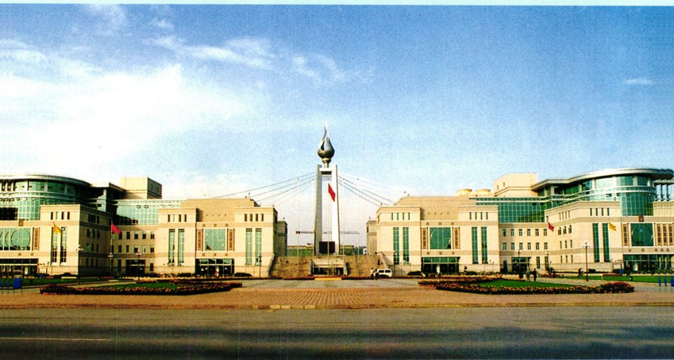
1998年建成的绵阳高新技术产业开发区火炬大厦
