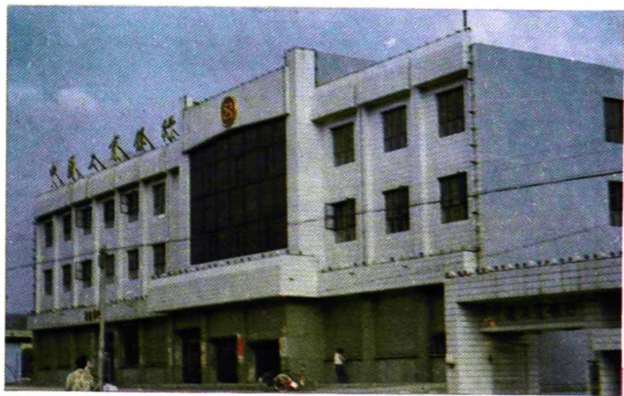
工商银行办公大楼全景
