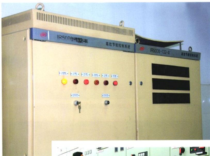
2005年节能改造后的IR5000-132-II型高效节能控制系统
