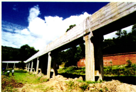
胜利水库渠系竹木山支渠伍家湾渡槽
