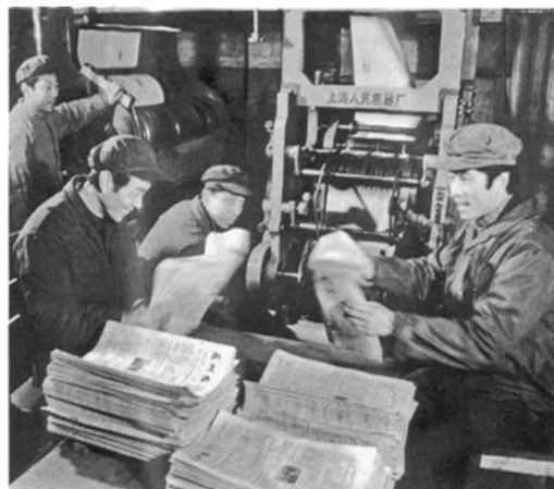
报社印刷厂“203小高速”铅印轮转机（上世纪80年代）
