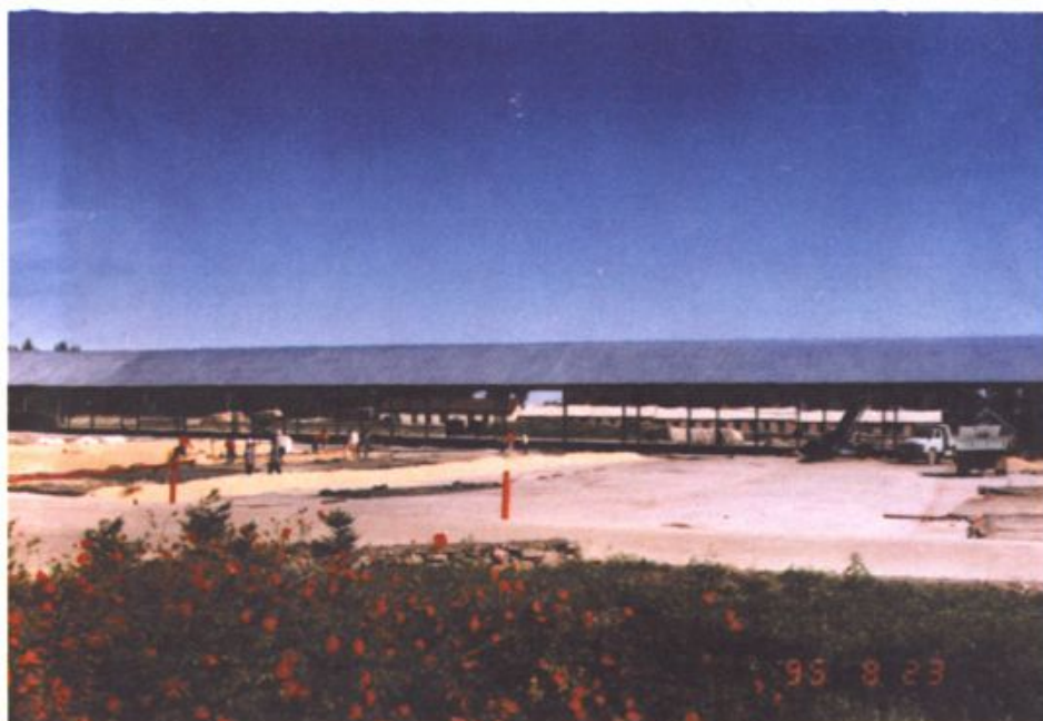
浸油厂北罩棚及晒台
