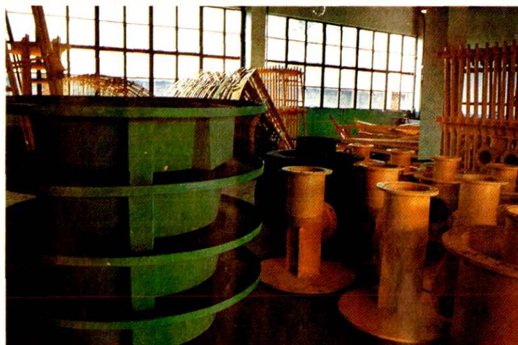
四川省成都市金牛玻璃钢厂车间一角
