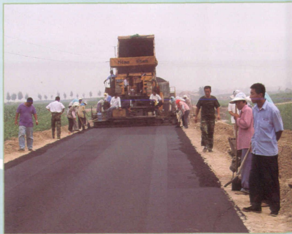
农村道路村村通施工现场
