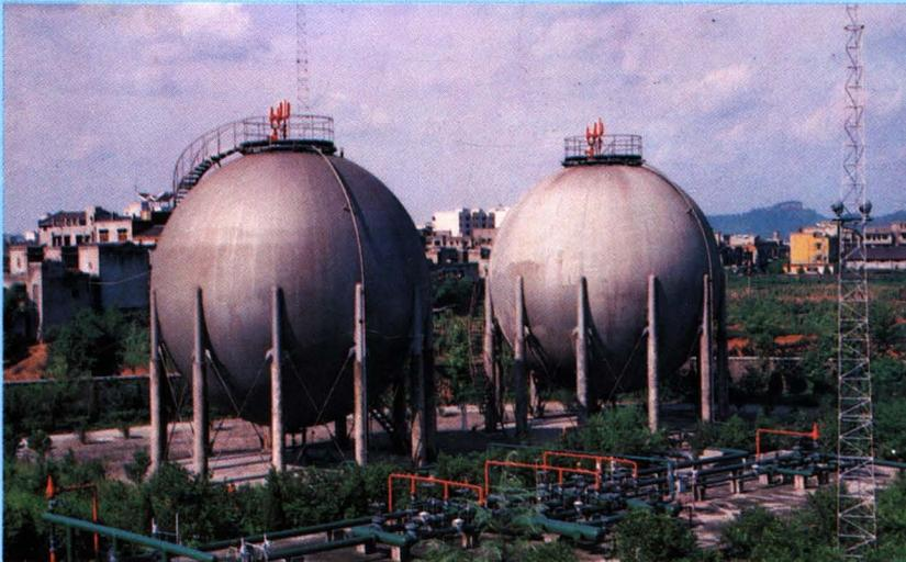
每个 1000 立方米的天然气配气站储气罐。城市日供气 3.4 万立方米, 气化率 88.6%
