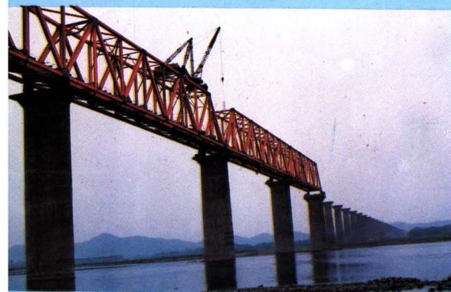
西南铁路第一长桥——达成铁路涪江特大桥,长4378.5米,桥墩(台)141个,最大跨度64米
