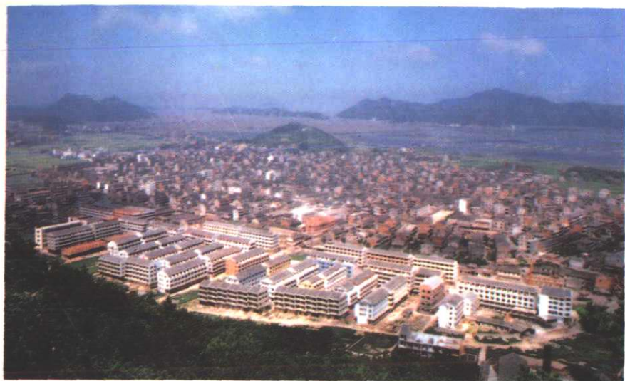
建设中的松门工业 业开发区
