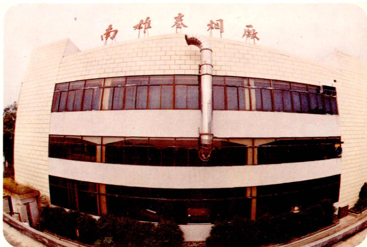
▲ 生产车间主厂房
