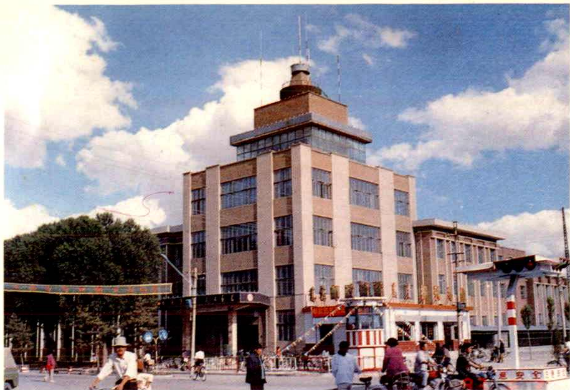
伊克昭盟邮电局邮电通信楼
