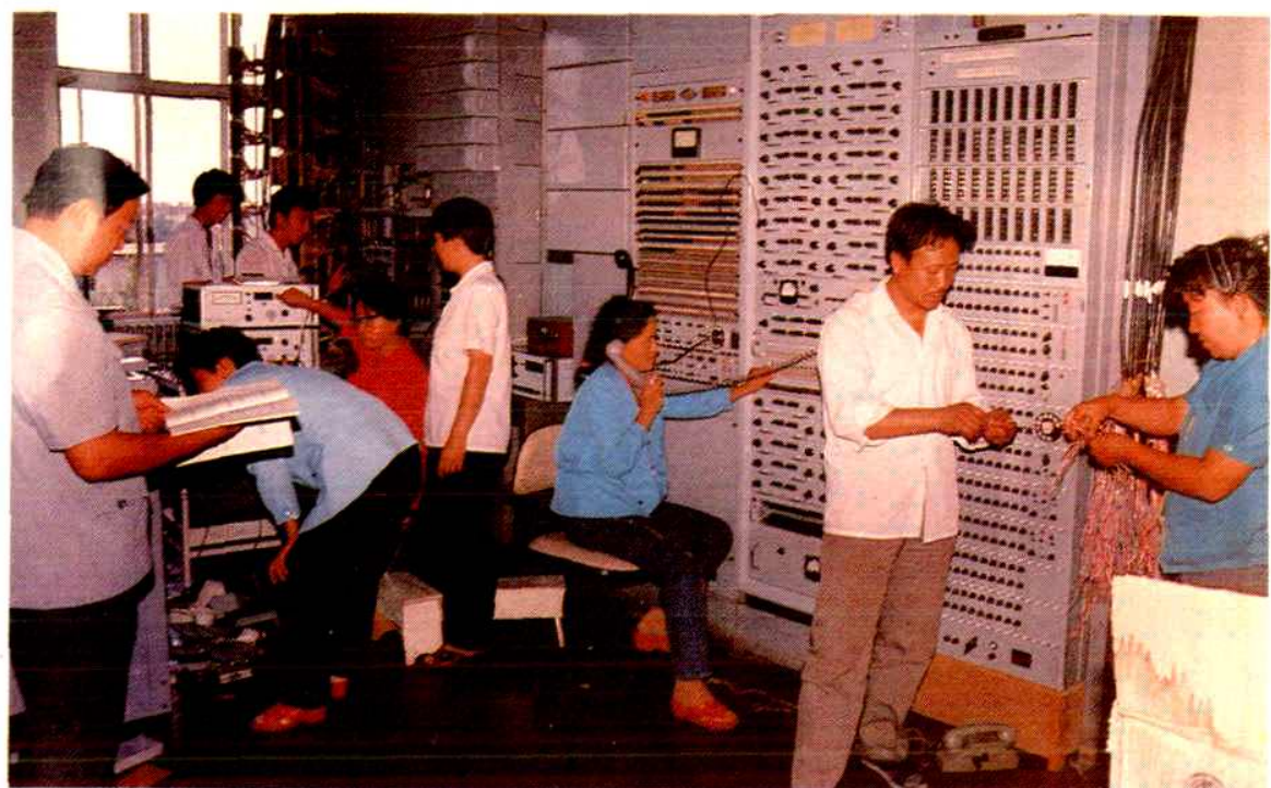
伊克昭盟邮电局载波机务员在安装设备
