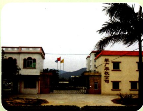
新广农牧发展有限公司办公大楼
