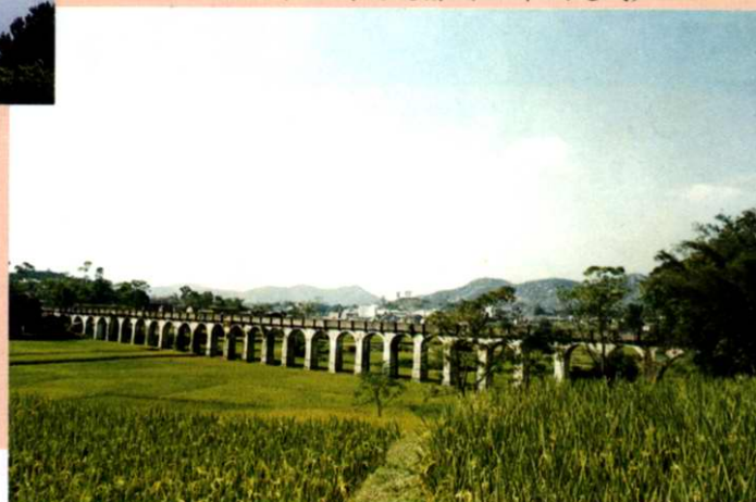
▽双底水渠高垌渡槽 (50年代建成)
