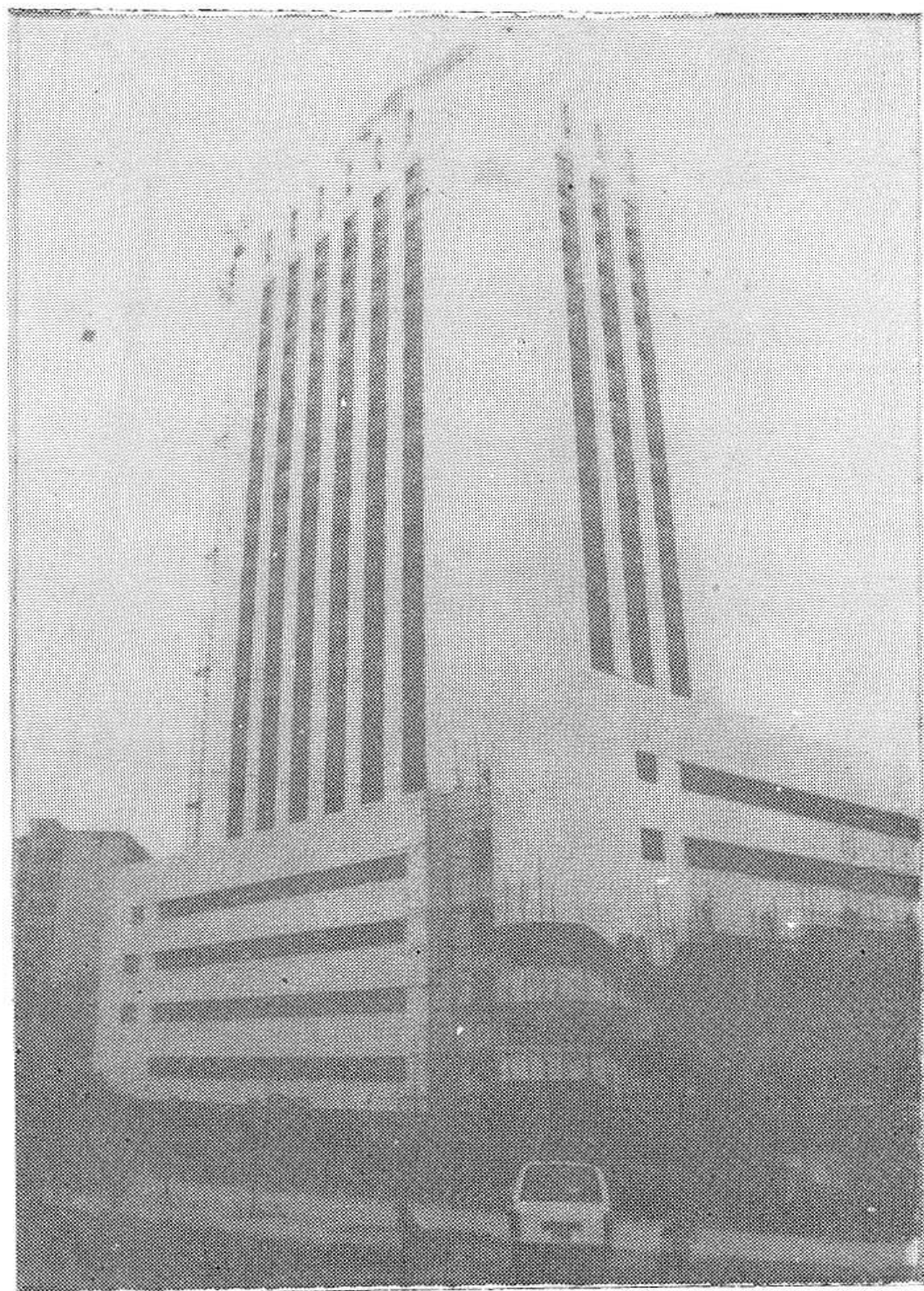
开发区24层外贸大楼正在施工中
