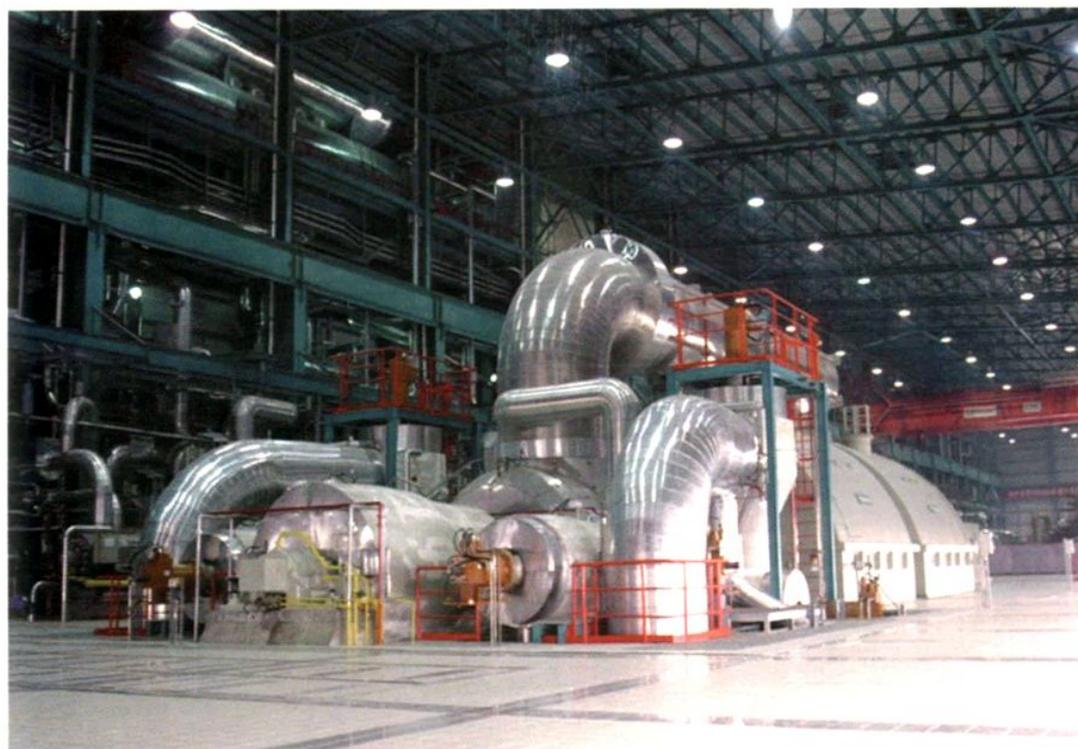
2002年，上海外高桥第二发电厂安装的享有“中华第一机”美誉的90万千瓦超临界凝汽式机组
