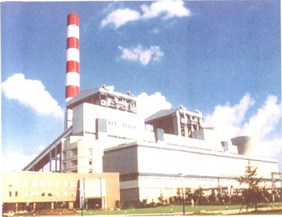
2001年建成的上海吴泾第二电厂，首次安装2台上海生产的60万千瓦发电机组
