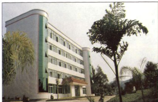
自来水公司办公大楼
