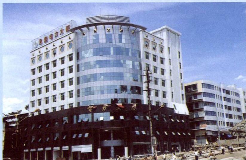
东门电力大厦
