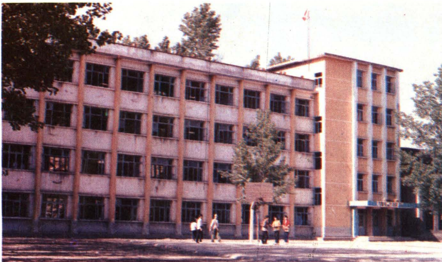
沿河第二中学教学楼
