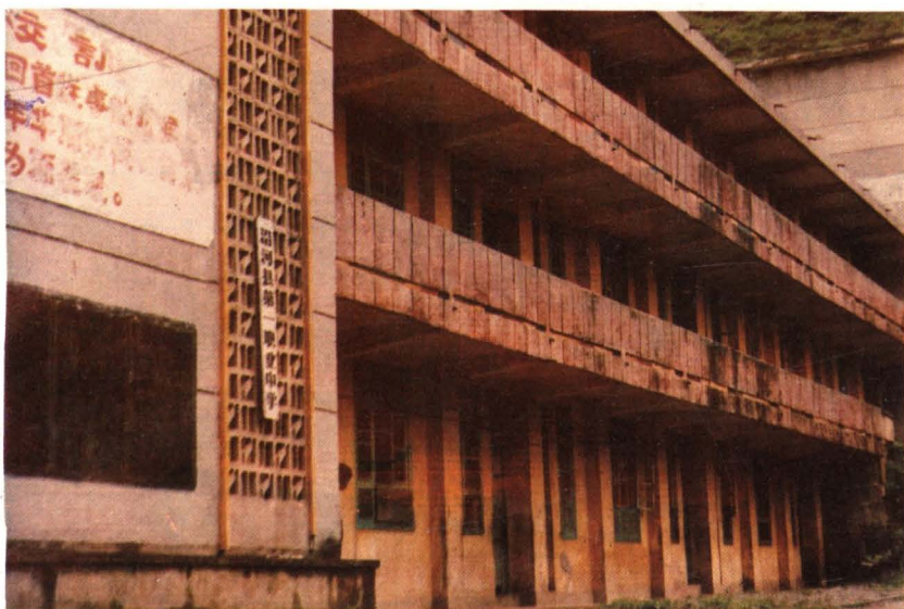
沿河第一职业中学教学楼
