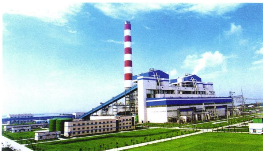
②⑪1999年6月20 日，一期工程2台60 万千瓦机组全部竣工投 运，单机容量为全省最 大的扬州第二发电厂
