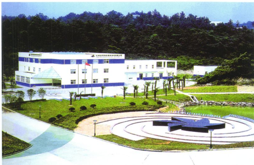
②④江苏首座抽水蓄能电站——江苏沙河抽水蓄能电站2002年7月30日工程全部竣工投运, 装机容量10万千瓦
