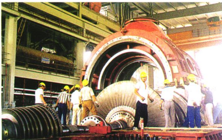
⑪1998年11月，江苏省电力建设第三工程公司安装省内首台60万千瓦汽轮机
