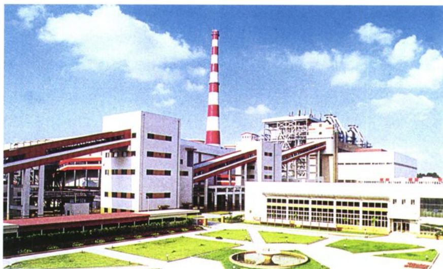
②⑫1999年7月16 日，技改工程全部竣 工投运、装机容量25 万千瓦的环保示范电 厂——南京下关发电 厂(2001年获芬兰政 府“卓越环保项目” 奖杯)
