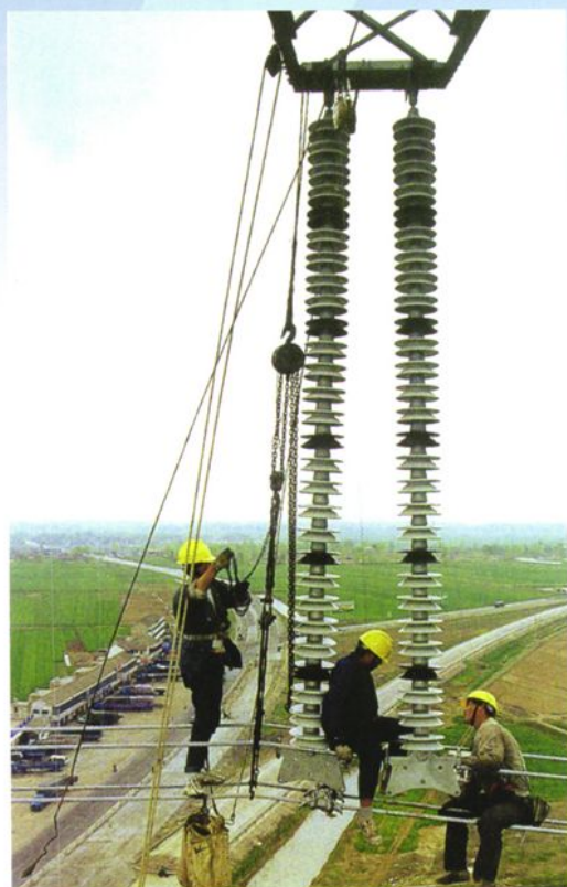
⑫江苏省送变电公司500千伏输电线路施工
