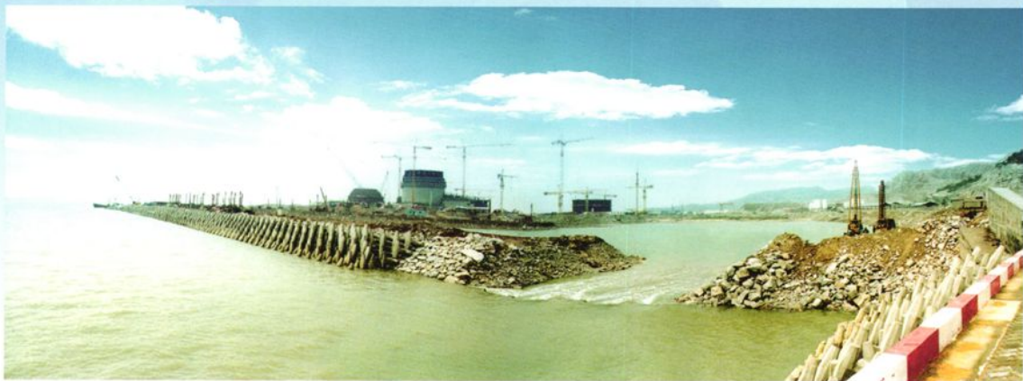
⑮田湾核电站工程施工中期全貌(2001年摄)
