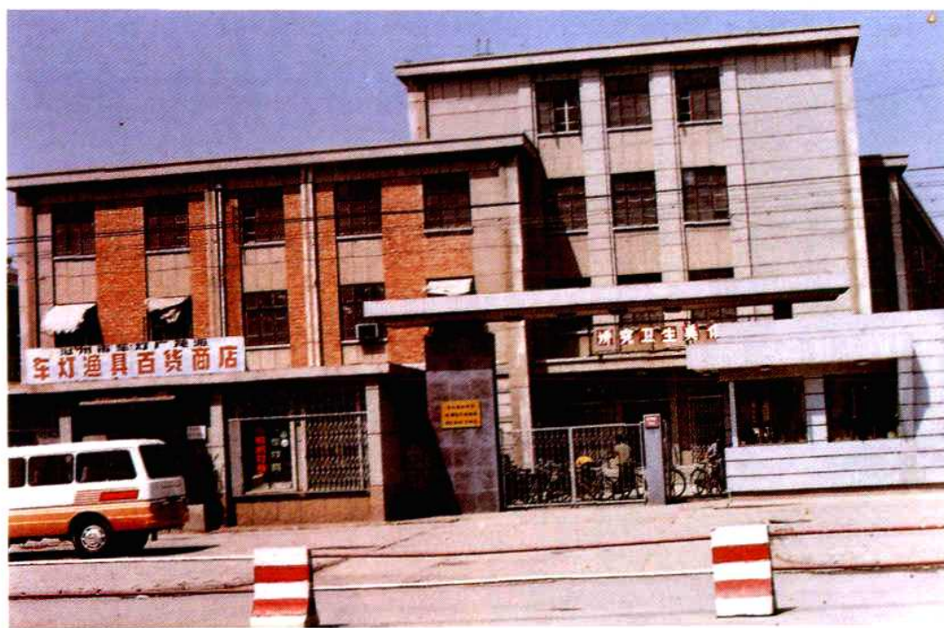
西环中街76号、沧州市机电局办公楼(1973年竣工)
