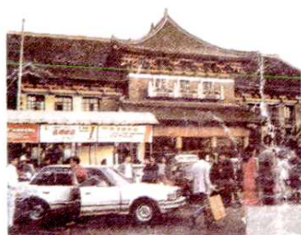
民国31年（1942年）重建后的杭州站，于1997年6月拆除
