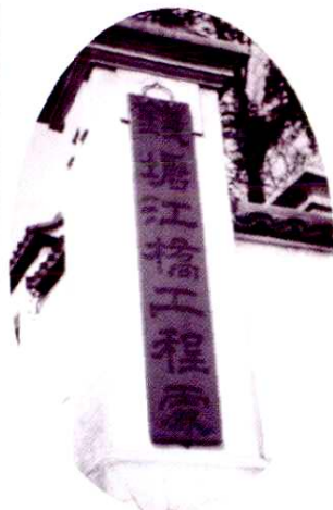
民国23年(1934年)4月,设在杭州闸口白塔岭的钱塘江桥工程处
