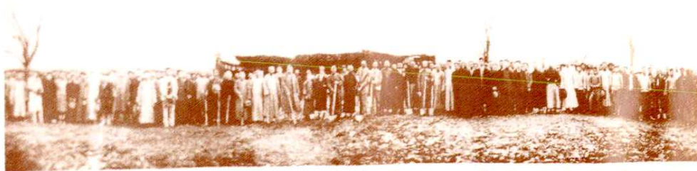
民国21年 (1932年) 11月, 杭江铁路金 (华) 玉 (山) 段开工典礼
