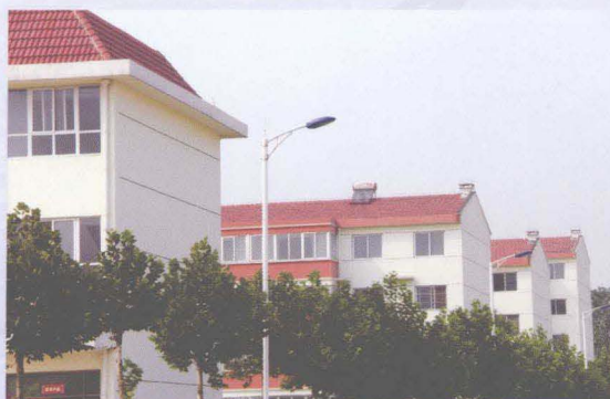
建成后的居民楼
