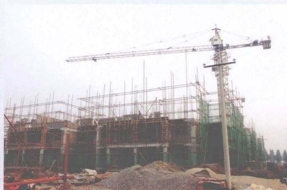
建设中的居民楼
