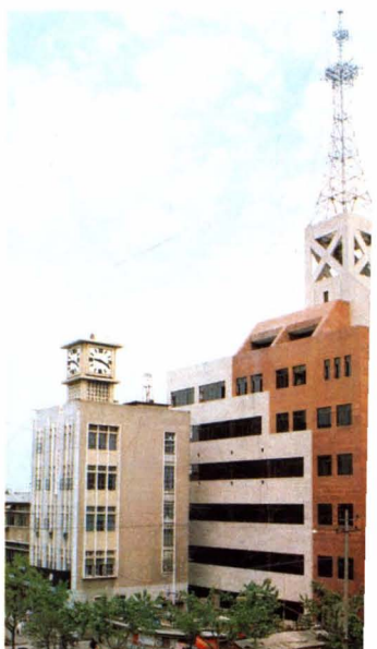
富阳电信程控大楼
