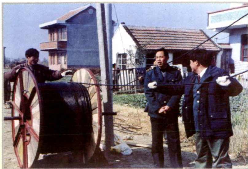
杆线到村工程 施工现场
