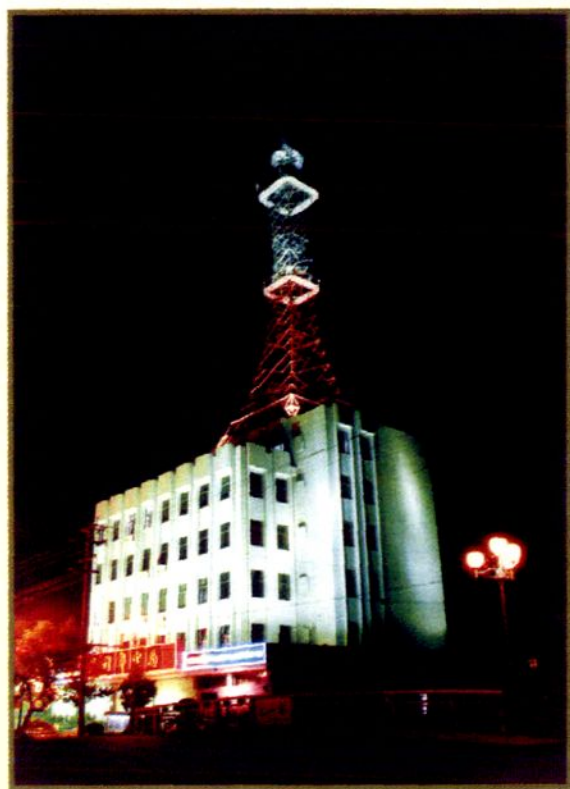
1989年5月建成的海门电信枢纽楼
