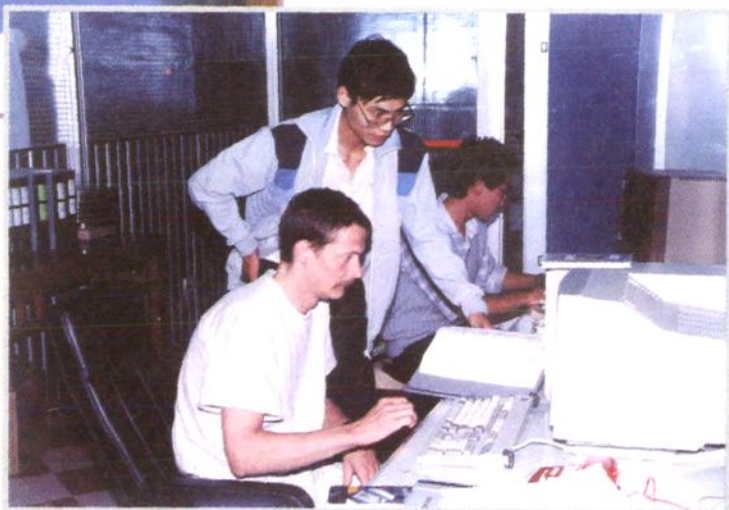
中外工程技术人员调 测程控交换设备
