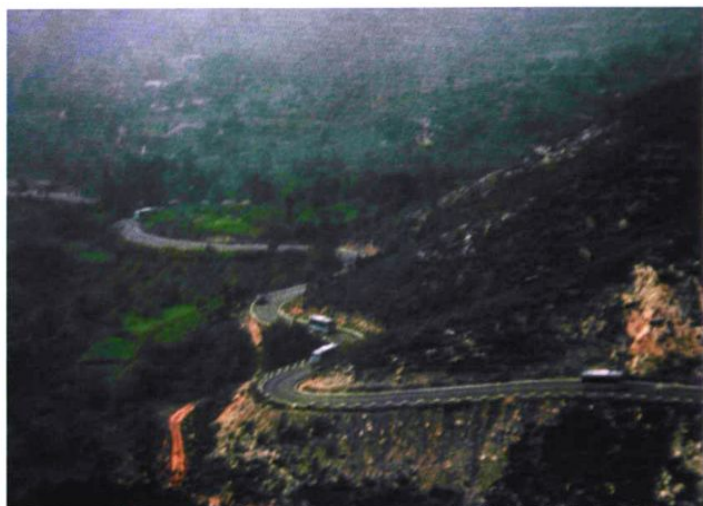
山区环线道路
