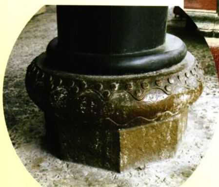
现存古建筑的各种石柱础及踏脚石
