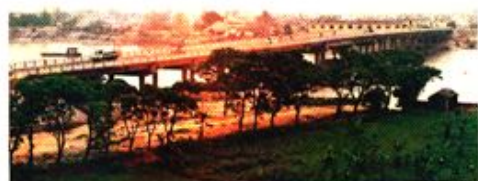
▲新建东里大桥。
