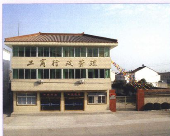
吕城分局办公楼
