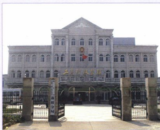
新桥分局办公楼
