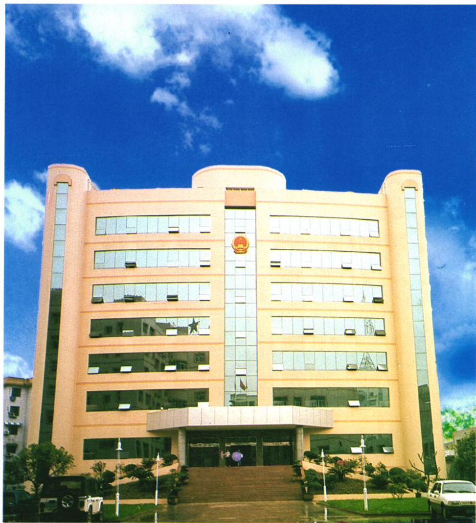
广安市人民代表大会常务委员会机关办公大楼
