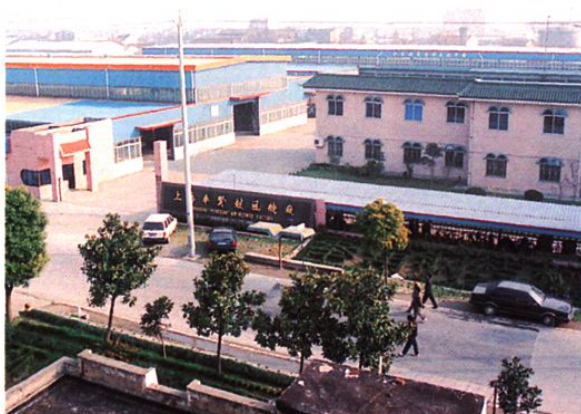
奉浦钢结构有限公司
