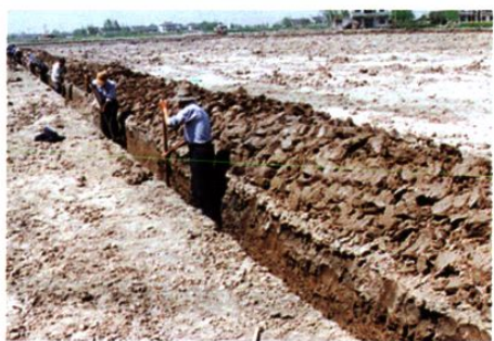
在平整区域开挖排灌沟渠
