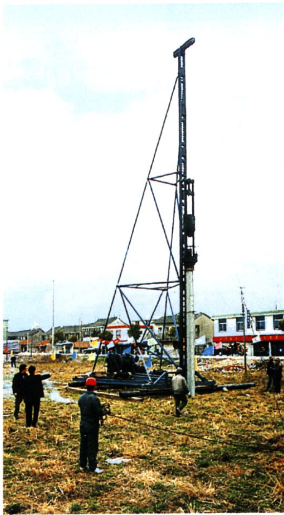
村科技大楼打桩开始
