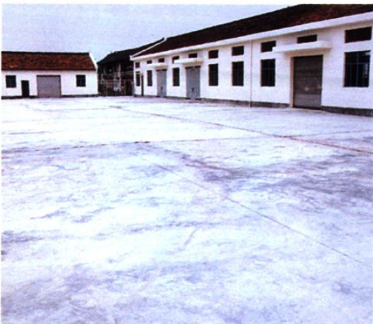
平整土地后的树园6组仓库场一角
