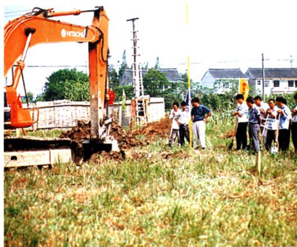
村委会大楼开工
