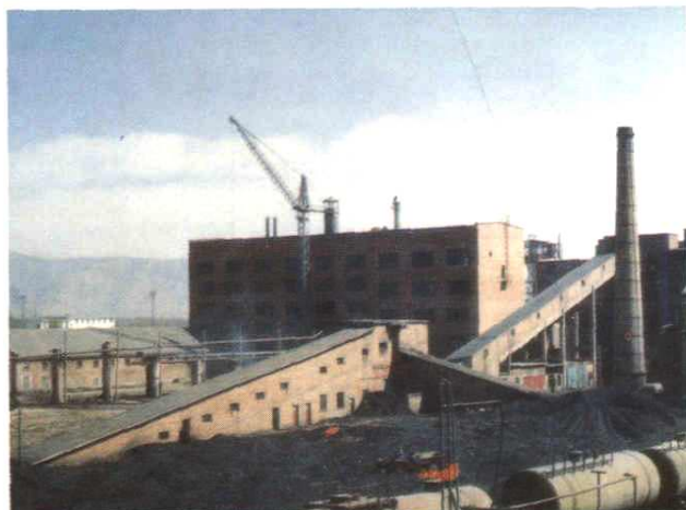
正在兴建中的颗粒粕车间
