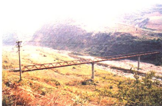
堰惠渠过堰河钢管渡槽
