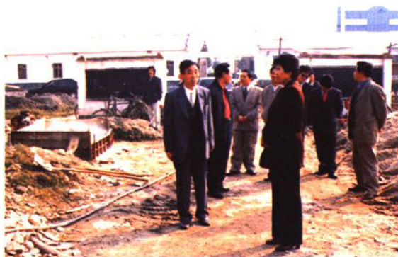
县长郑洁等县上领导检查二水厂建设工程
