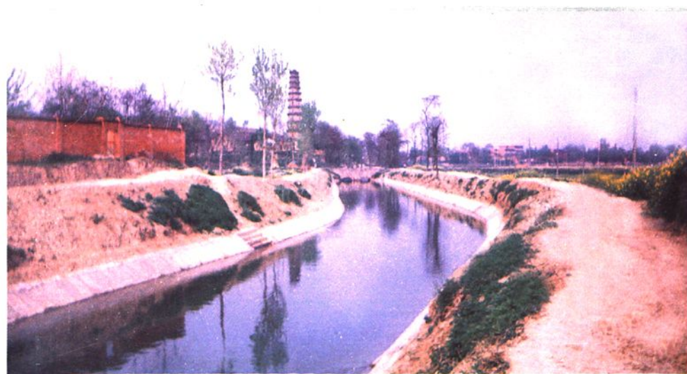
汉惠渠北干渠武侯段渠道
