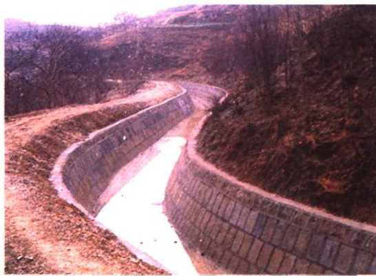
幸福渠渠道防渗工程之一段
