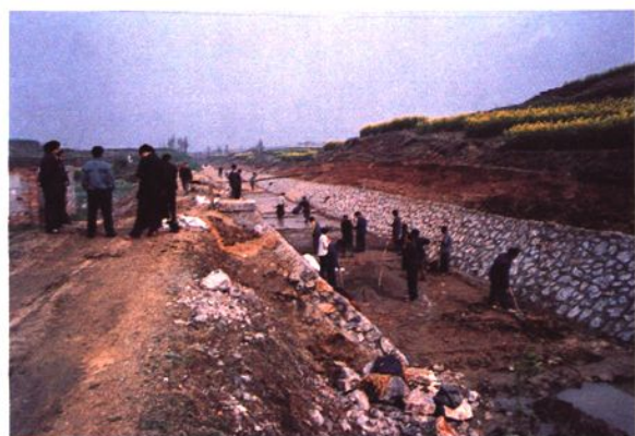
汉惠渠北干渠改造工程施工现场
