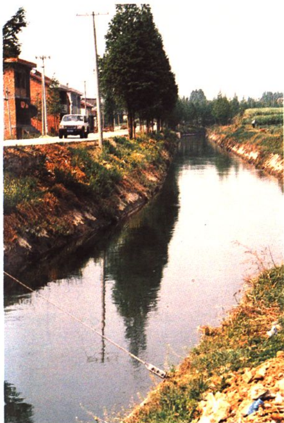
汉惠渠北干渠周家山段渠道
