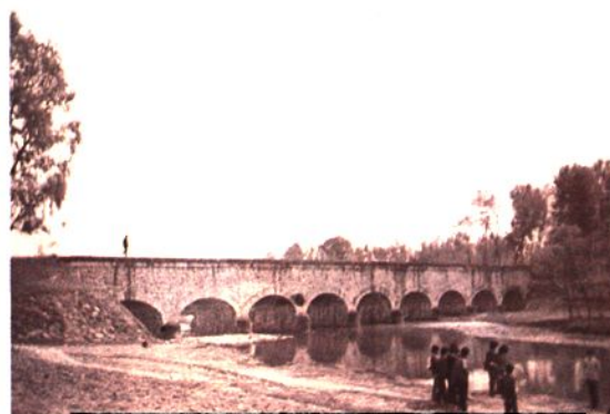
汉惠渠北干渠跨黄沙河渡槽
