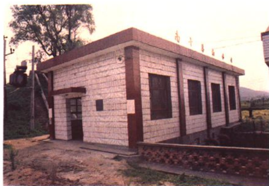
汉惠渠南干渠抽水站
