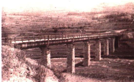
华阳河“U”型薄壳渡槽外貌
