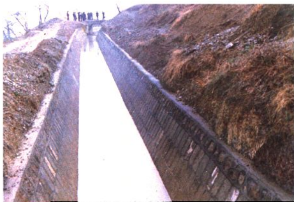
幸福渠干渠改造工程
