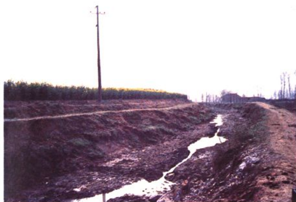
改造前的汉惠渠北干渠渠道
