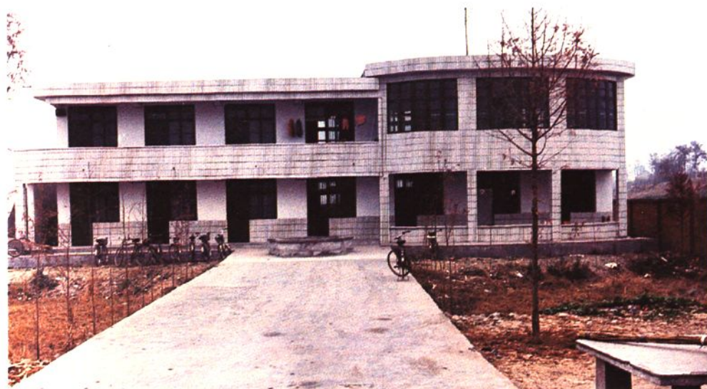
王家湾水管站
