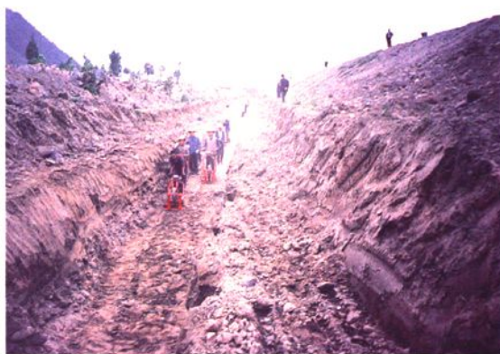
汉惠渠北干渠改造工程施工现场
