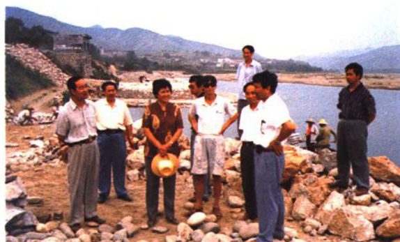
县长郑洁（左三），副县长陈庆生（左一）等县上领导检查水毁修复工程。
