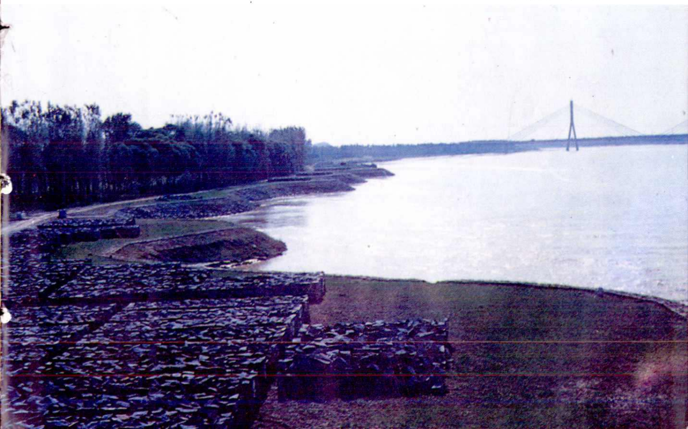
3 张褚窝控导工程
