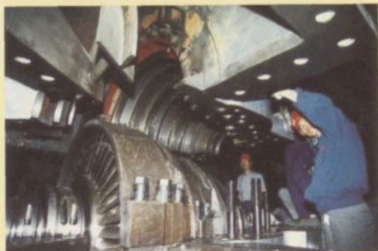
中华电力菏泽电厂300MW 汽轮 机施工。 (范丙丁摄)
