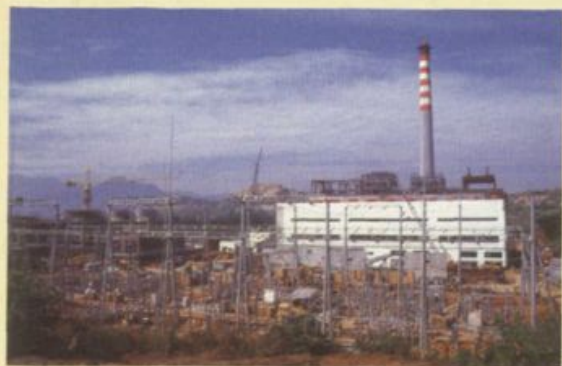
公司承建的第一个国外工程印度 Malco 电厂。
