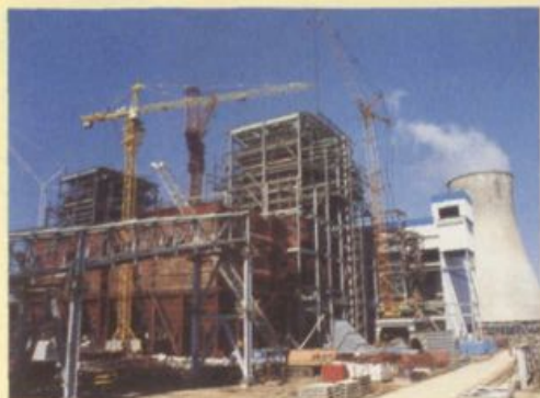
施工中的华能德州电厂660MW 机组。 (朱荣春摄)
