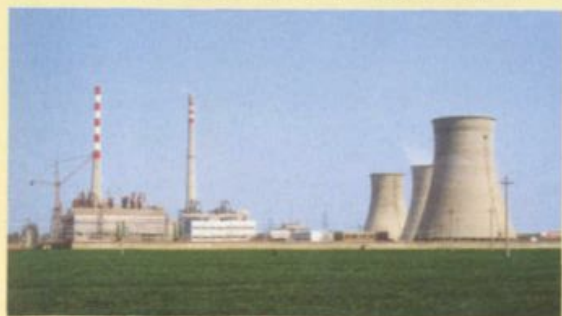
公司承建的第一个司法部项目山 东里彦电厂 (总容量 370MW)。
