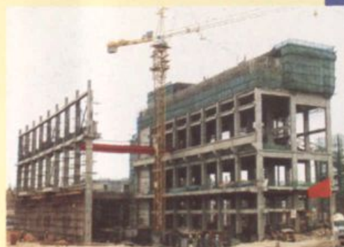
公司中标承建的西部开发 项目新疆喀什电厂主厂房。 (殷伟摄)
