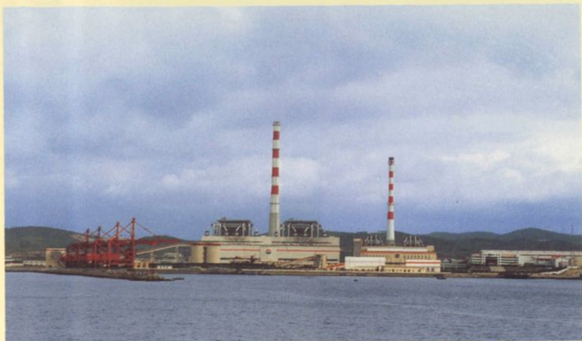
公司承建的华能威海发电厂，总容量850MW。
