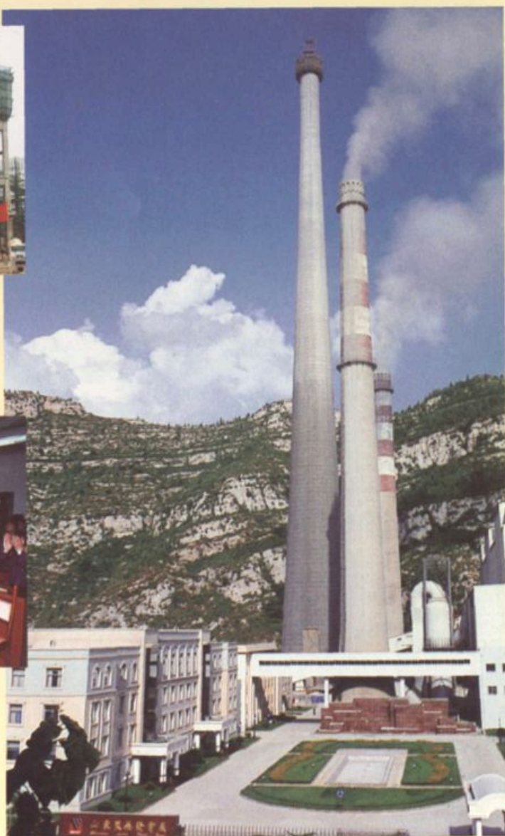
公司承建的莱芜电厂改造项目260米烟囱。
