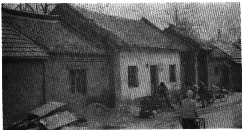
3—2—5—1 四角硬房（白墙为四角硬房）
