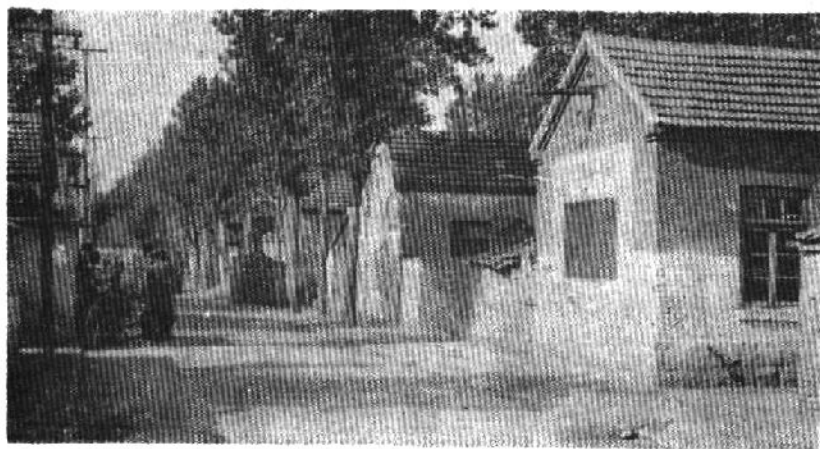
3—2—4—6之二 砖墙、瓦屋顶
